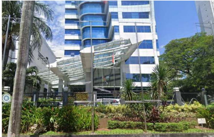
Gambar 1 Gedung D Direktorat Jenderal Guru Dan Tenaga Kependidikan
